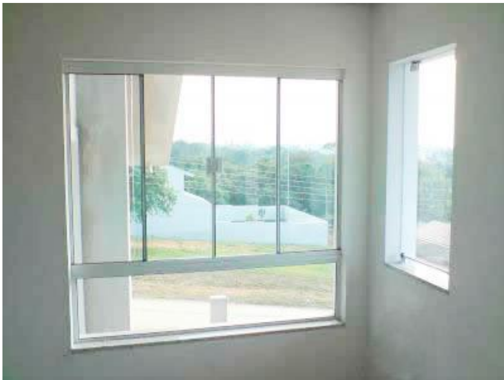
IMAGEM 10; correr 4 folha Com Peitoril Alumínio Branco A=2,00m X L=2,50m
