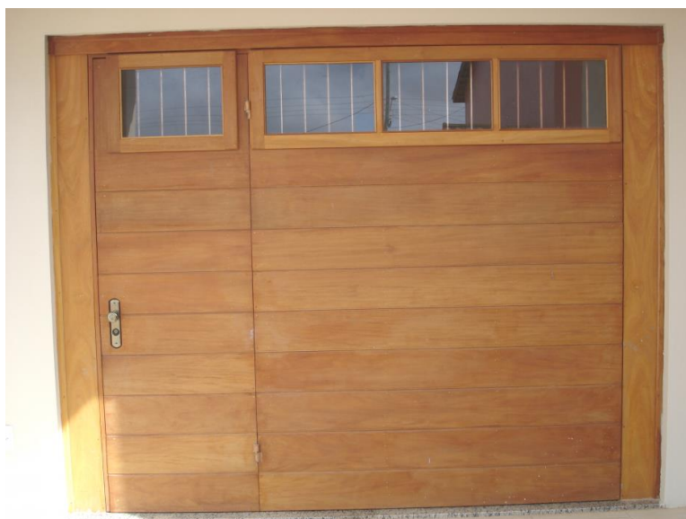
IMAGEM 6; Portão basculante lambri horizontal de madeira maciça, com porta, vidros e grades
